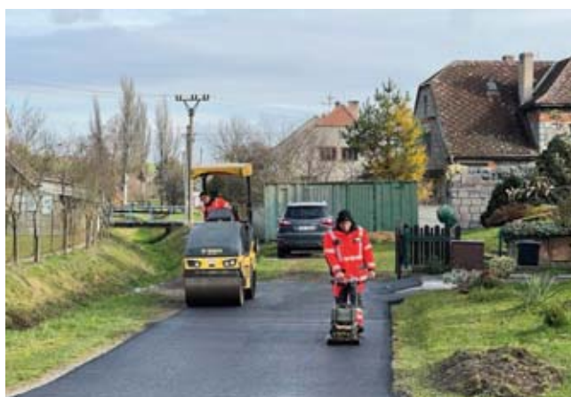
Oprava komunikace pod školkou
