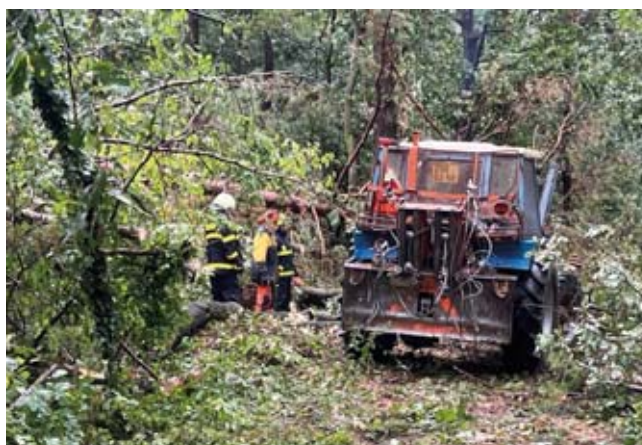
Čištění po větrné kalamitě
