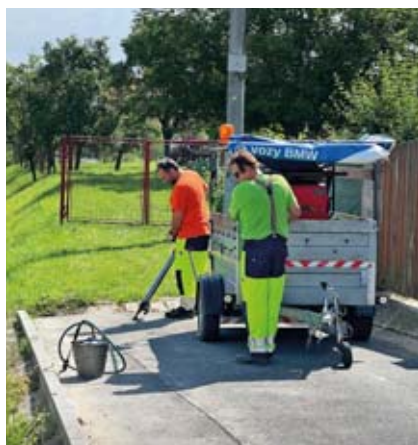
Zálivka spár na komunikacích
