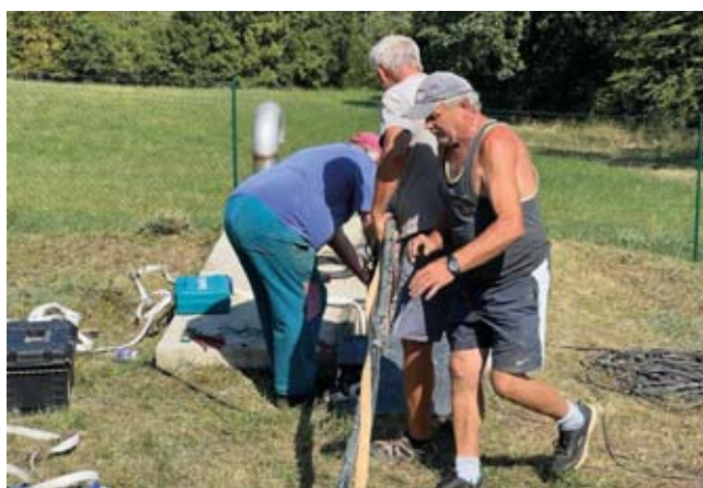
Oprava čerpadla ve vrtu
