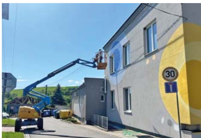
Čištění fasády mateřské školy
