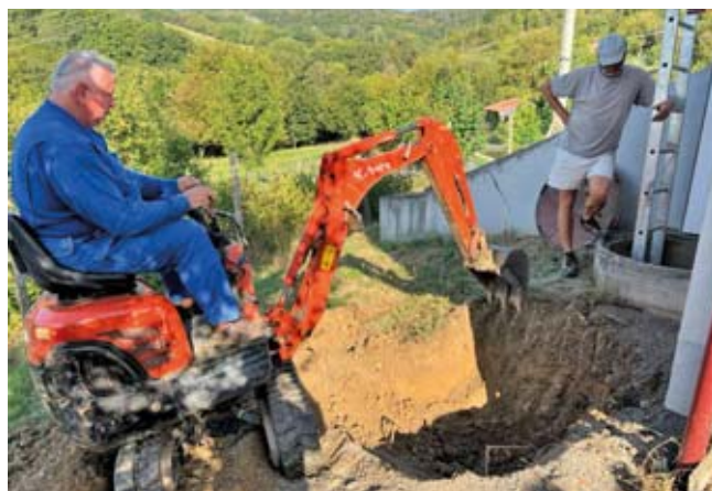
Oprava u vodojemu
