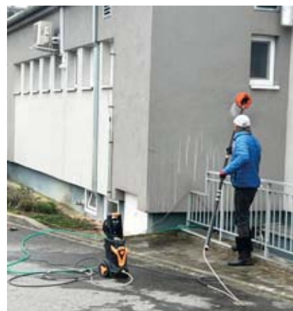
Čištění fasády mateřské školy
