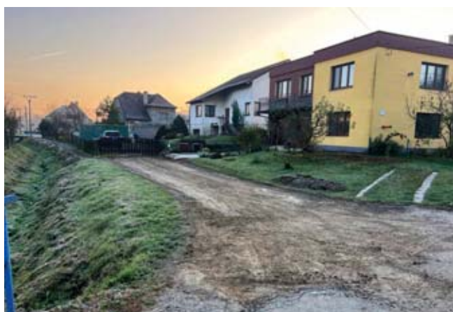
Oprava komunikace pod školkou
