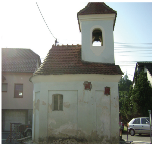
Kaplička před rekonstrukcí
